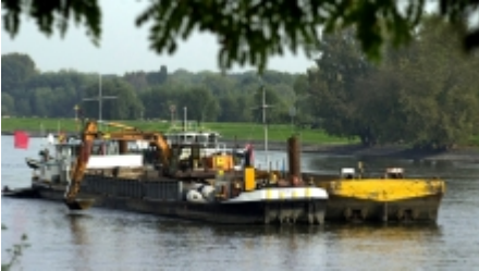
Das Baggergut aus der Elbe hat es offenbar in sich.
